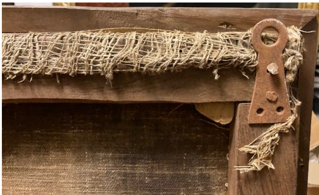
FOTO 4. Falsi margini vecchio restauro
