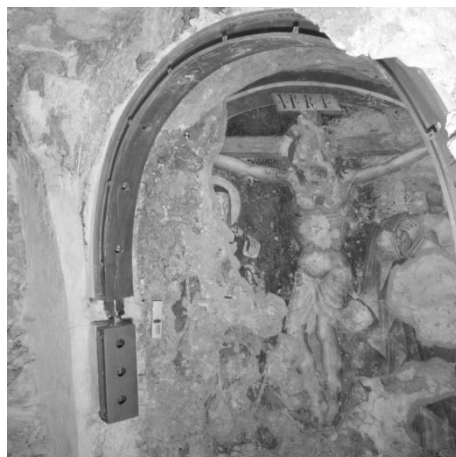
Figura 15 – Appoggio a muro del gazebo in corrispondenza dell'affioramento roccioso
