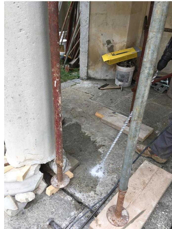
Sottomurazione e inserimento barre filettate inclinate
