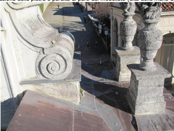
Stato della copertura in piombo e delle parti lapidee delle pire
