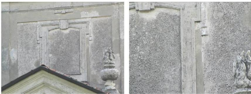
Presenza di alveoli da erosione da forte vento, con deposito di particellato e attacco biologico
