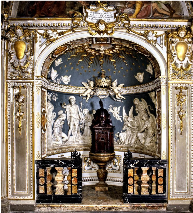
Il Battistero del 1699 venne ristrutturato da Ludovico Pogliaghi nel 1984
